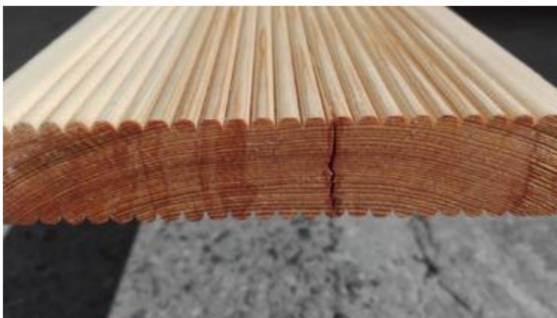
Fot. 6 - pęknięcie czołowe, przechodzące
